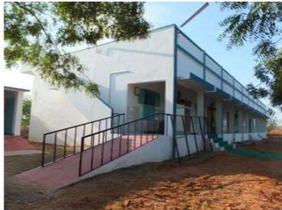
完成した多目的訓練センター
