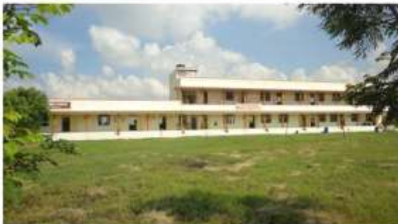
完成した実業学校舎
