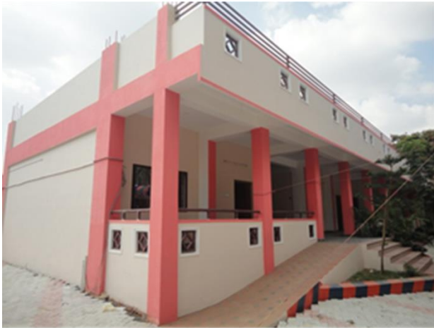
完成した校舎
