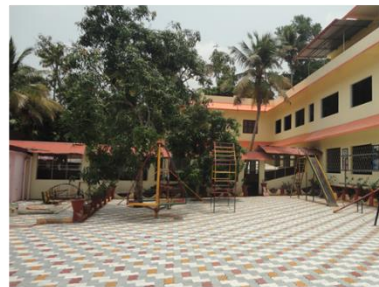
完成した寄宿舎
